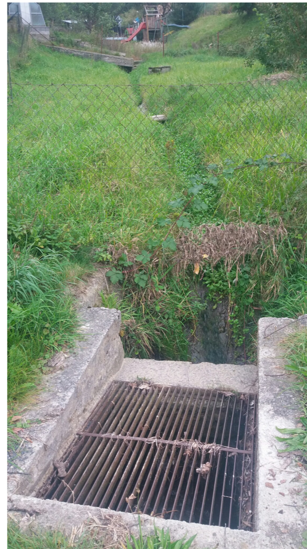
Vpusť nad domem č.p.164 jejíž ucpání při přívalovém dešti způsobilo zaplavení domu
