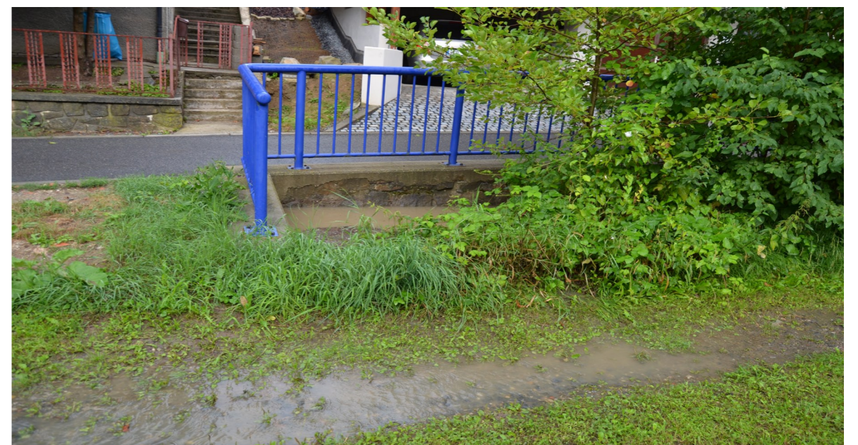
Ucpaná propust v ulici U potoka před domem č.p.209
