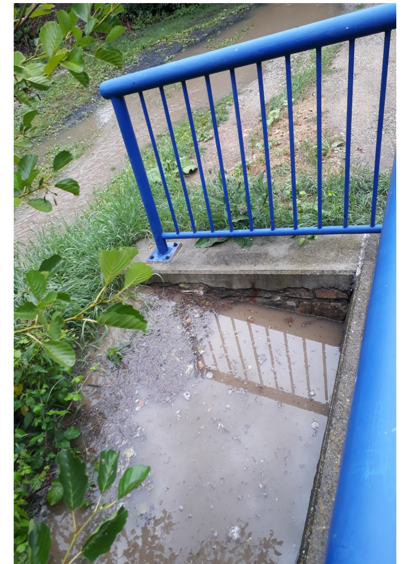
Ucpaná propust v ulici U potoka
